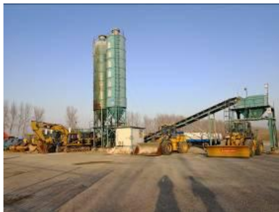
已建成的搅拌站
